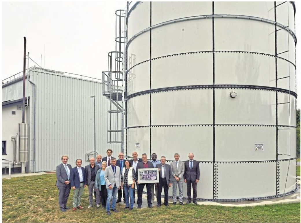
Ins Auge sticht der Faulturm erweiterten Kläranlage. Mit dem hier entstehenden Gas wird elektrischer Strom zum Betreiben der Anlage erzeugt. Neue Zulaufpumpen und eine modifizierte Belüftung sparen ein Drittel der Energie. Zur Einweihung kam Ministerin Ulrike Höfken mit Gefolge. Foto: Werner Dapui
