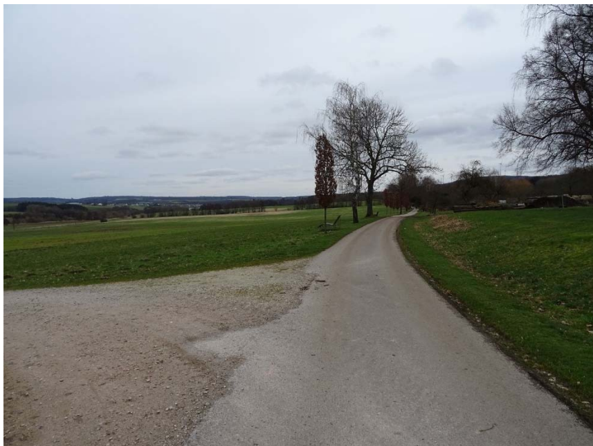
Foto 1 Blick nach Osten über den Kohlweg und das Plangebiet
