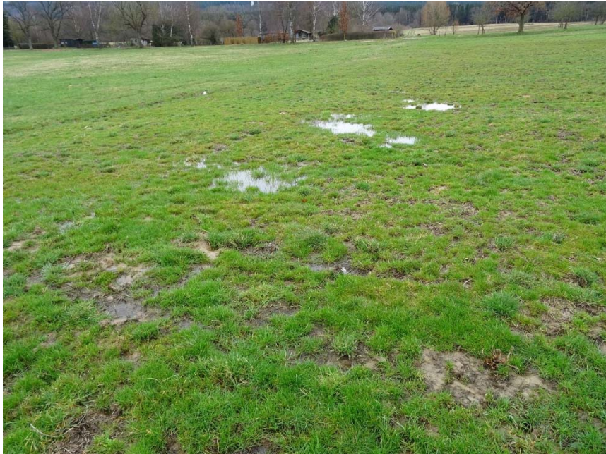
Foto 8 Vernässte Bereiche im Februar 2024
